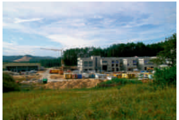
Allein auf weiter Flur ohne Unterstützung aus der Bevölkerung gelingt es uns trotz Pressefahrten, Petitionen etc. nicht, das Industriegebiet Velden Nord mitten in der fünffach geschütztem Dolomitekuppenalb zu verhindern.
