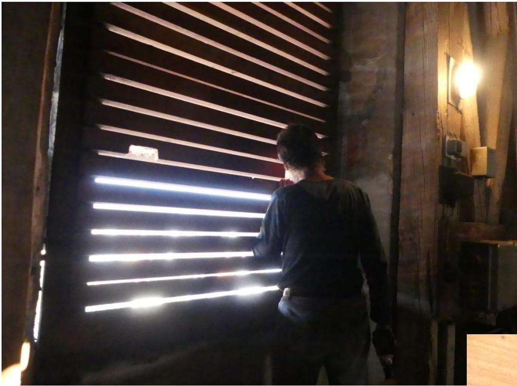
Die Schalladen-Spalten werden auf gut 50mm erweitert, damit Mauersegler in die Kästen einfliegen können.
