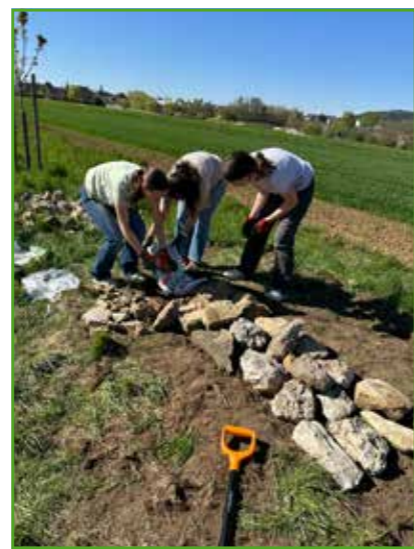
Bau einer Steinmauer
