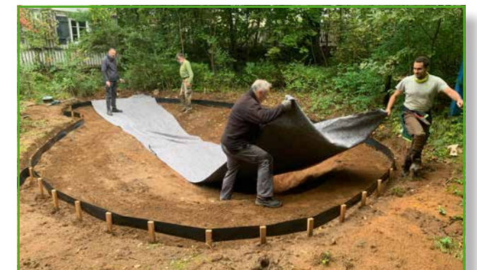
Verlegen von Vlies als Unterlage für die Folie
