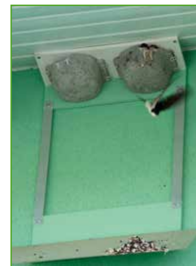
Abb. 5: Aluminium-Bänder von 50 cm Länge beschleunigen die Annahme und minimieren das Risiko für die Nestlinge von Beutegreifern erreicht zu werden. In windigen Lagen besteht aber die Gefahr des Aufschaukelns.
