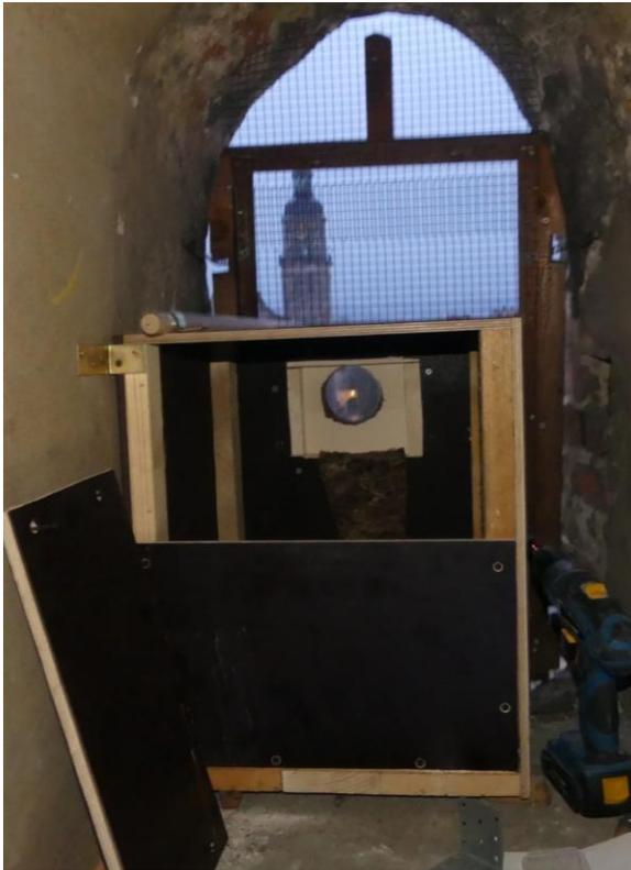
**Abb. 7:** Geöffneter Dohlen-Kasten in der Ost-Fassade. Der Nistkasten ist in Laibung und Boden fest verschraubt. Das Gitter wurde nur vor den Einflugöffnungen entfernt.
