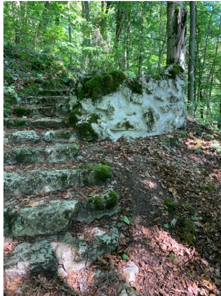
Ausbessern von Mauerfugen am Frankenstand
