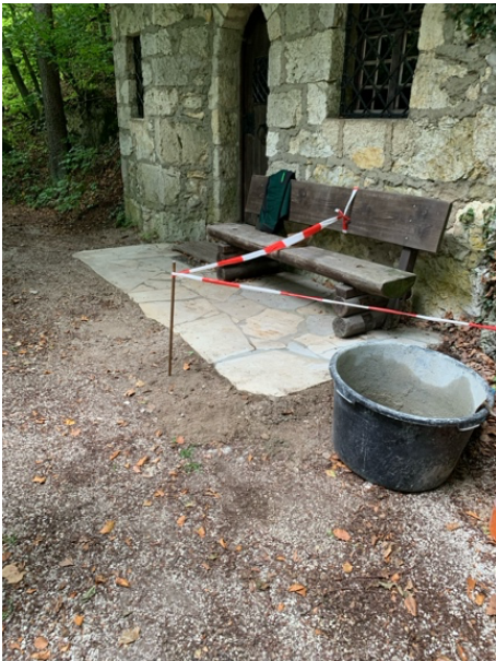
Ausbessern von Platten am Infohaus
