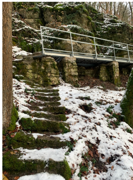
Einbau einer fast neuen Brücke (brauchbare Teile wurden wiederverwendet)
